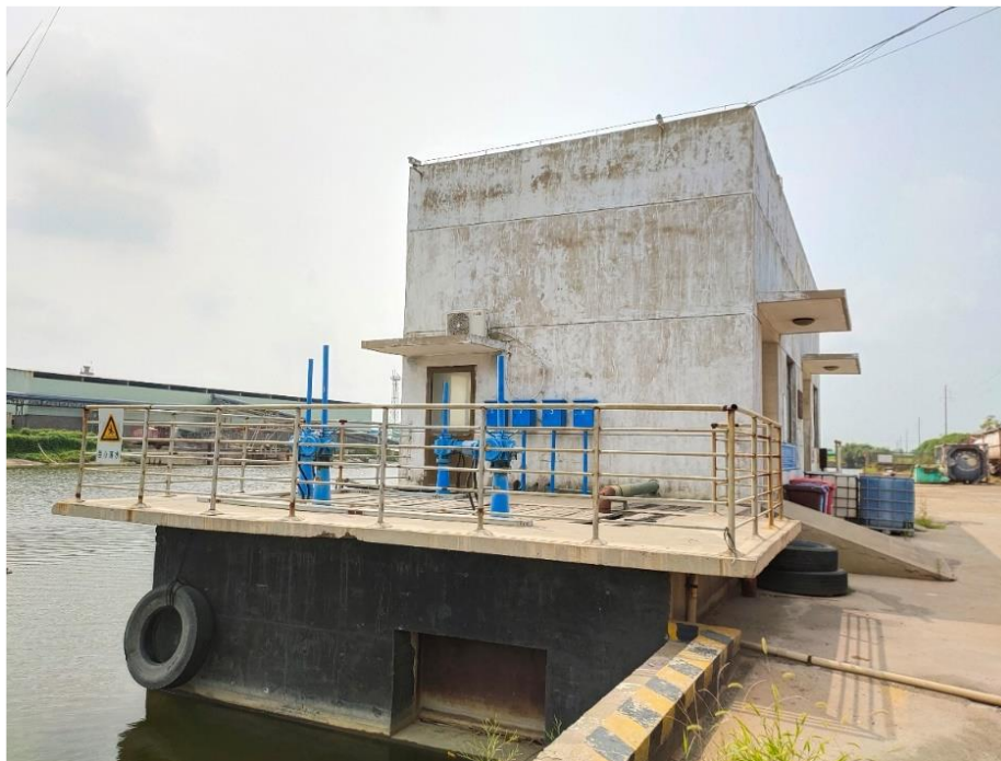
图 7.7.1-2 如东县洋口化学工业园（西区）应急截污池
